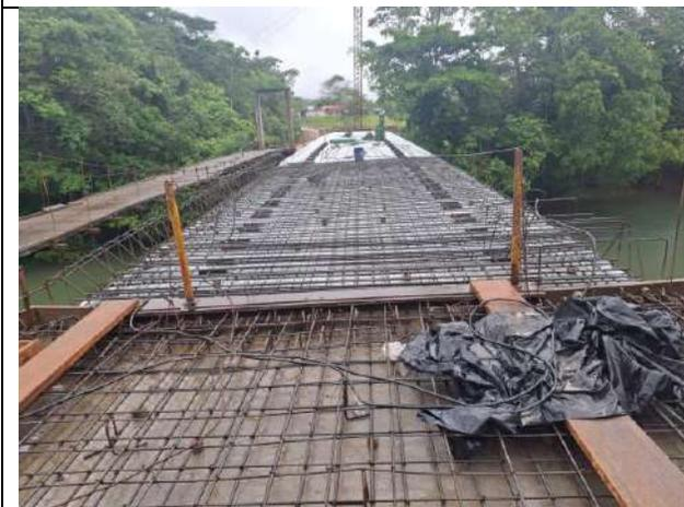
Evidencia del proceso de instalación del acero sobre plataforma como soporte de la calzada del puente nuevo (año 2024)
