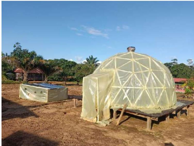
Figura 7. Secador solar diseñado por el Instituto SINCHI y construido de manera conjunta con la comunidad de Wacurabá para el secado de frutos y semillas de Copoazú
