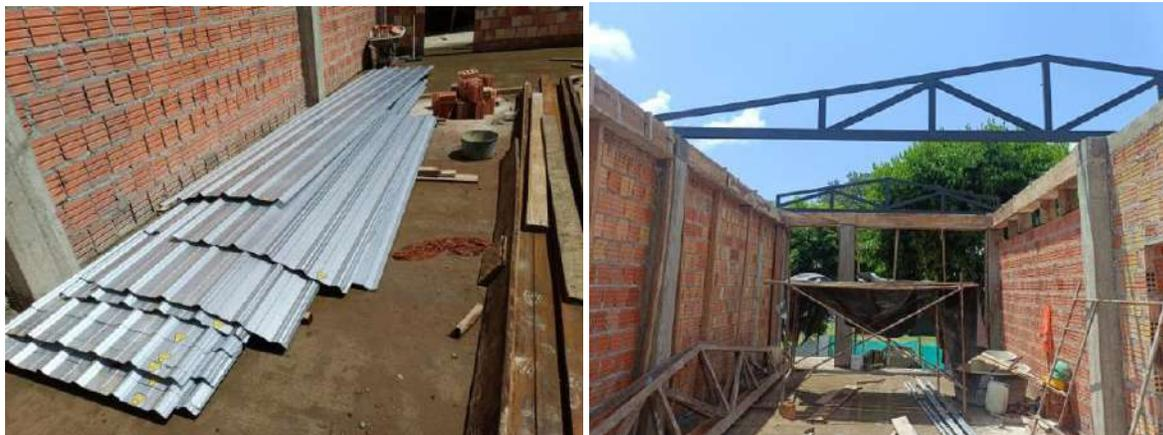
**Figura 5.** Avances de las adecuaciones de la planta piloto de bioempaques en Puerto Nariño, Amazonas: A. Detalle de piso y encerramiento periférico; B. Detalles avance de estructura para la cubierta. Fuente: UT Planta Bioempaques Amazonas
