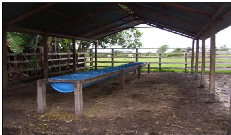
Establo construido para sistema semiestabulado, Municipio El Retorno.
