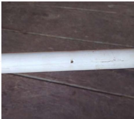
**Figura 34.** Agujero en el tubo a instalar en el tronco, para permitir la salida del aire.
