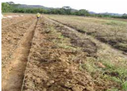
**Figura 16.** Construcción de Zanjas.
