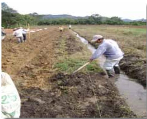
**Figura 15.** Descapotado del terreno.
